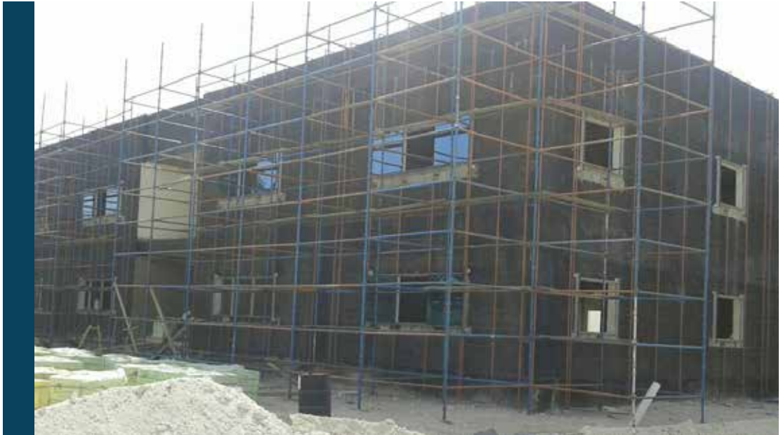
انشاء وتشطيب مبنى المكاتب الإدارية إنماء للحديد
