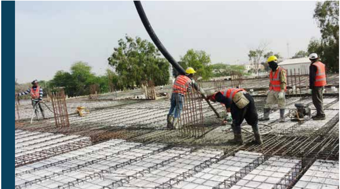
إنشاء مصنع ملك الخالدي (محمد الودعاني) CONSTRUCTION OF AL KHALEDY FACTORY
