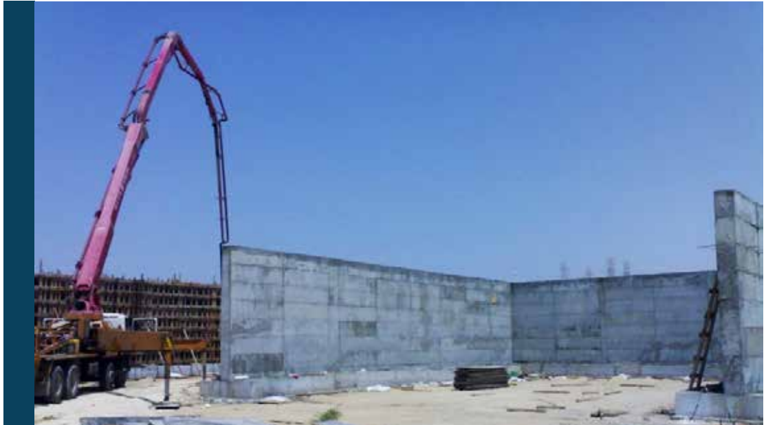
مشروع إنشاء محطة خلط الأسفلت ملك السبيعي جروب
