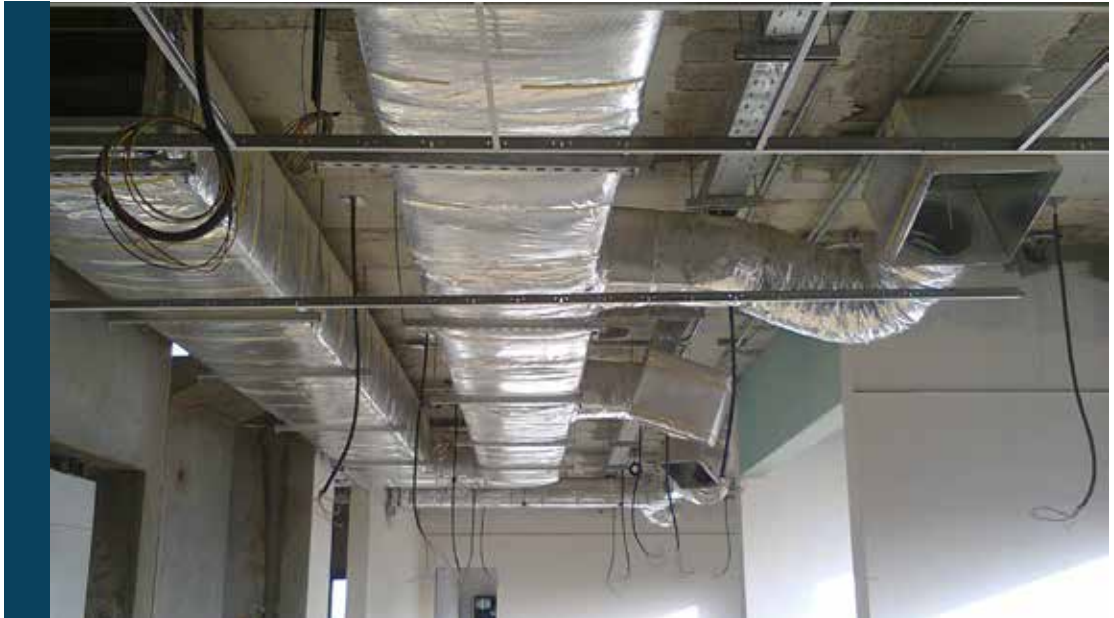
أعمال تكييف وتشطيب مكاتب مصنع الطاقة الكامنة
