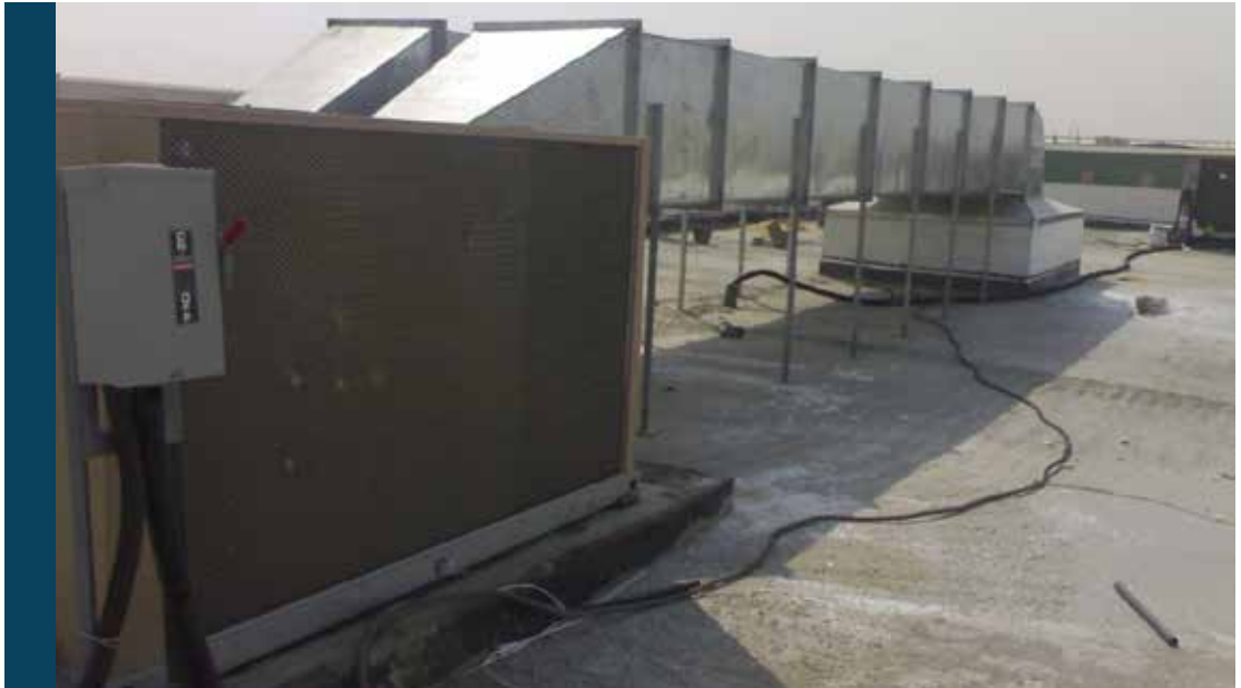
أعمال تكييف تشطيب مكاتب مصنع ماريثايم
